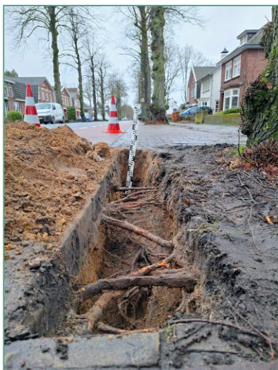
Foto 315 Diepte profielsleuf en aangetroffen beworteling
