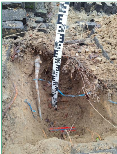
Foto 7 Afgedopte slang, diepte profiel
