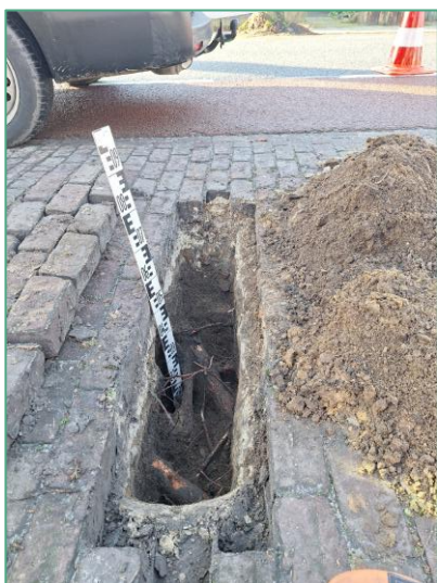
Foto 23 Diepte profielsleuf
